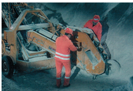
Salzladeförderband mit Becherwerk
